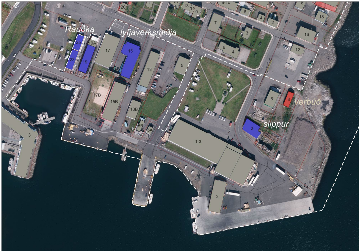
15. mynd. Tillaga húsaskráningar að hverfisvernd (blá hús) og friðuð hús (rautt hús).
