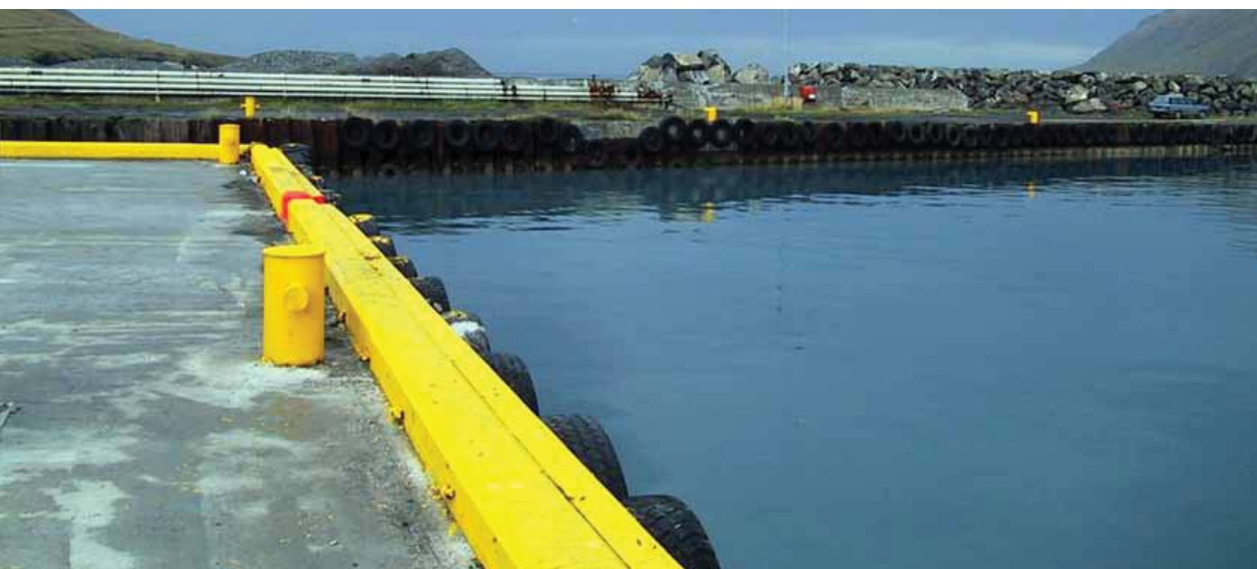
Mynd 40 Frá Hafnarbyggju á Siglufirði
