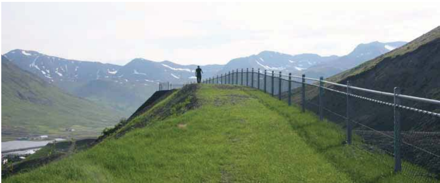
Mynd 12 Snjóflóðavarnargarður á Siglufirði
